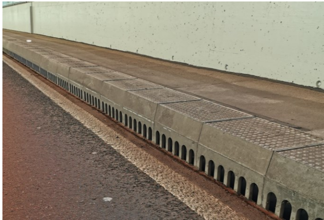
Fig. 5.12 Système de caniveau pour un pont avec couvercle de rinçage
