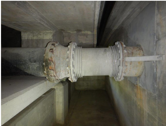
Fig. 5.11 Compensateur dans la chambre de visite de la culée d'un pont
