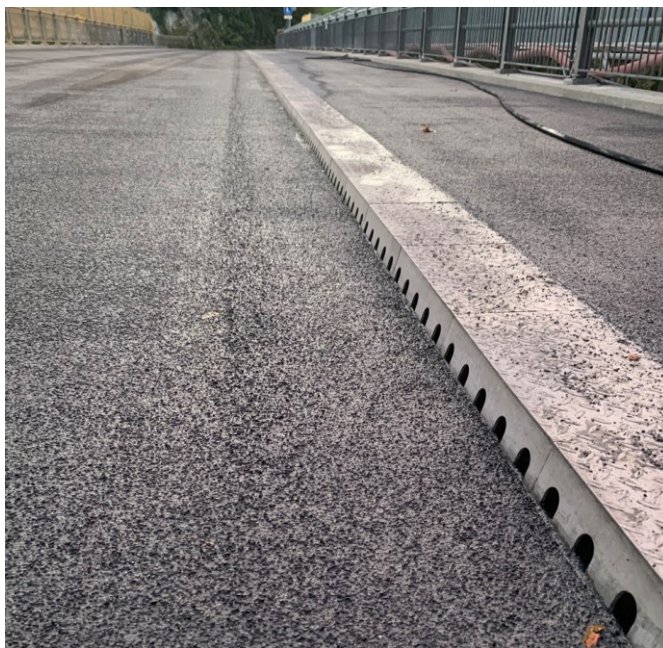
Fig. 5.13 Système de caniveau pour un pont (photo de chantier)
