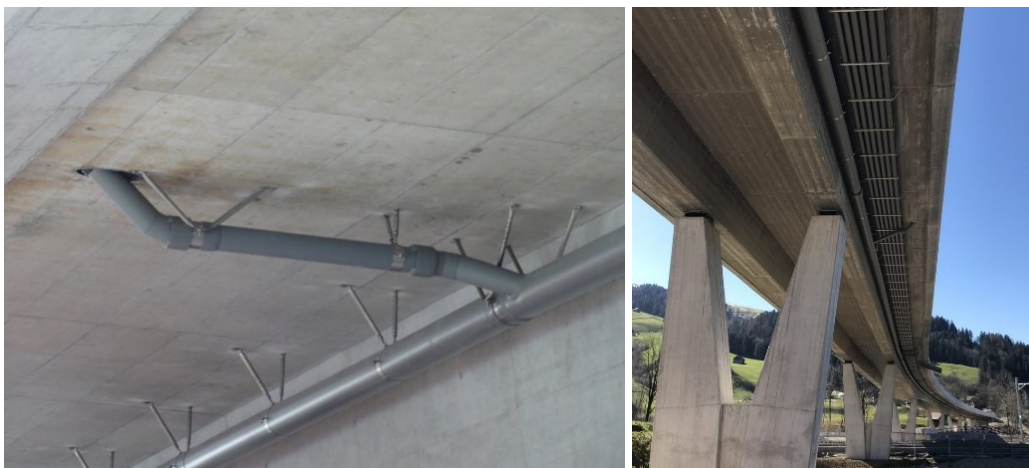
Fig. 4.3 Exemple d'une conduite avec des tuyaux gris et des manchons de couverture électrosoudables (à gauche) et pont avec des conduites grises (à droite)
