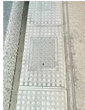
Fig. 5.12 Système de caniveau pour un pont avec couvercle de rinçage
